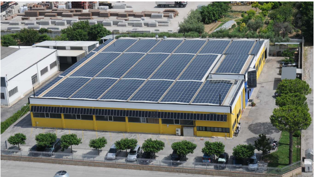
Figura 2 – Veduta della copertura dello stabilimento in pannelli fotovoltaici
